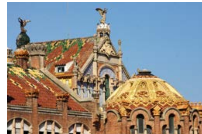
Roof of the Hospital de la Santa Creu i Sant Pau (Barcelona). Picture: Amadalvarez.
