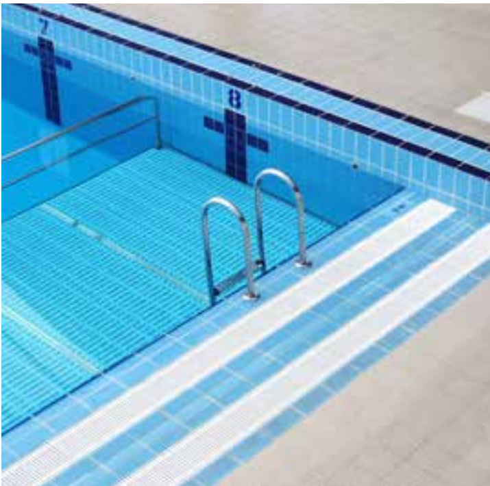
Detalle de piscina deportiva / Sports pool detail Borde Finlandés / Finnish edge
